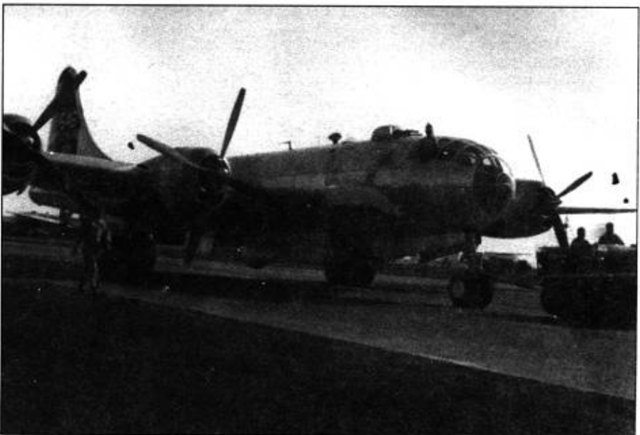
В-29 из 468-й группы откатывается на стоянку тягачом, Кхаразпур, Индия. Начиная с серии В-29-5 самолеты уже не окрашивали. Рисунок на носу фюзеляжа еще незакончен.
