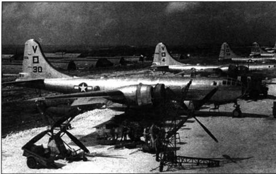
330-я техническая группа проводит модификацию двигателей R-3350 на B-29 из 499-й группы, Айли-Филд, Сайпан, ноябрь 1944 года.
