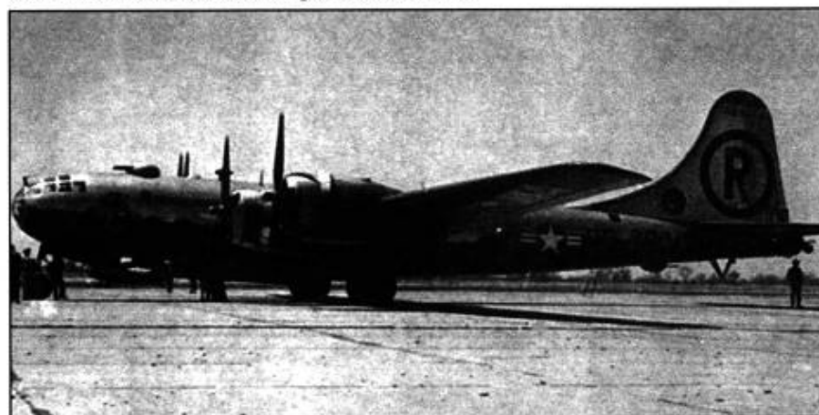
B-29B «Pistol Packin' Mama» из 28-й группы 15-й воздушной армии США, Рейнд-Сити. Нижняя сторона самолета выкрашена в черный цвет. Хвостовая пулеметная установка оснащена радаром APQ-15.
