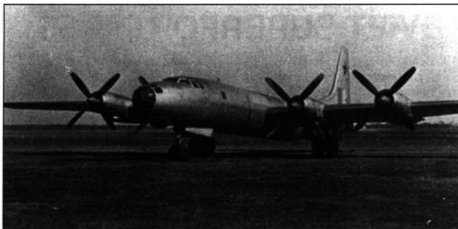
Ту-80 заменил Ту-4. Самолет имел ступенчатую носовую часть фюзеляжа, крыло сдвинуто назад. Этот силуэт стал характерным для самолетов Туполева.
